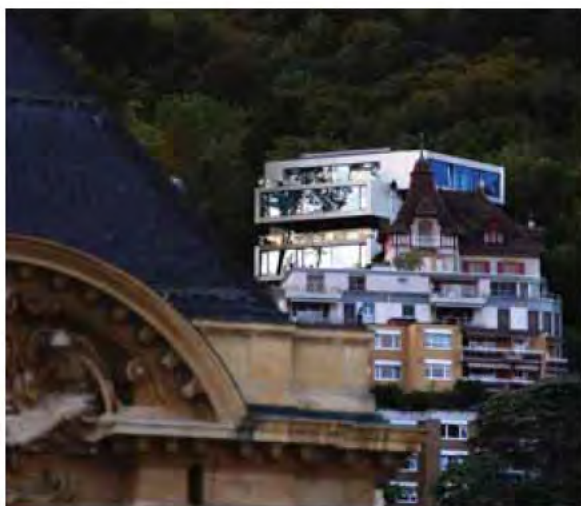
Succession de bâtiments, avec au premier plan l'Hôtel des postes, au centre-ville de Neuchâtel, et tout au fond l'immeuble de l'Ermitage. PHOTO SP-GÉRALD SCIBOZ
