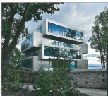
Ci-dessus : La nature, écran complexe, et ses reflets en trompe-l'œil dans les vitrages et sur le revêtement en aluminium élisé.
